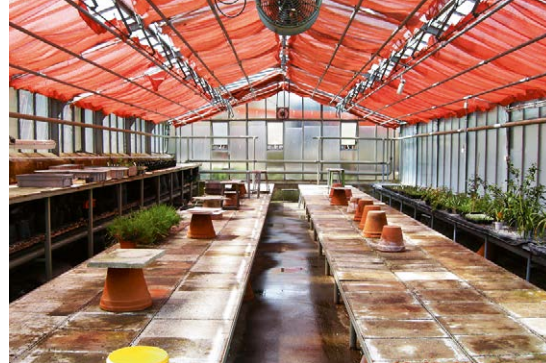
▲ Zustand vor der Neuerrichtung
